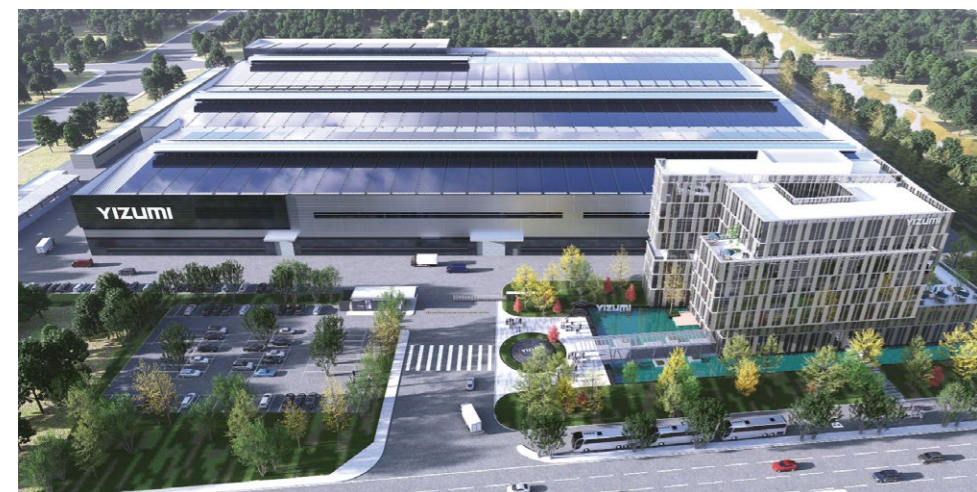
■ 伊之密华东基地(建设中)
